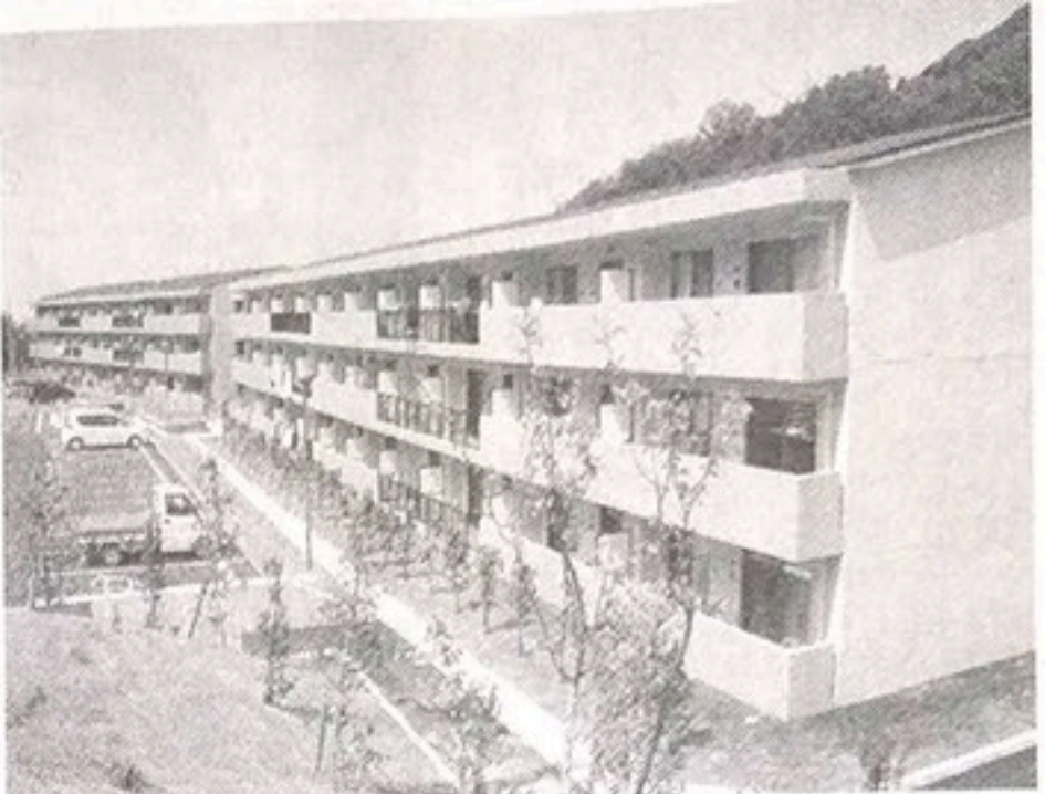
3月に完成し入居している人もいるY-2棟(手前)。奥はY-1棟=下香貫八重で
